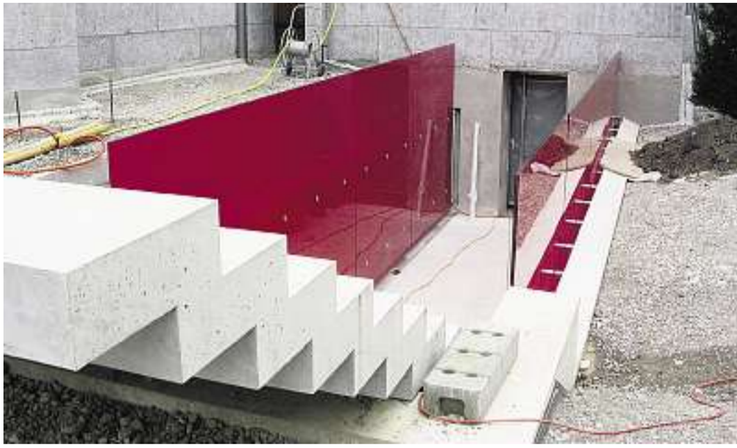
Noch wird gebaut: Aber Treppe und Wände markieren schon den Weg zum Raum der Stille in St. Jakob
